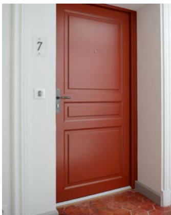
Porte palière moulurée et sécurisée
