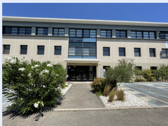
Les Pléiades III - 320 avenue Archimède - Aix-en-Provence (13)
